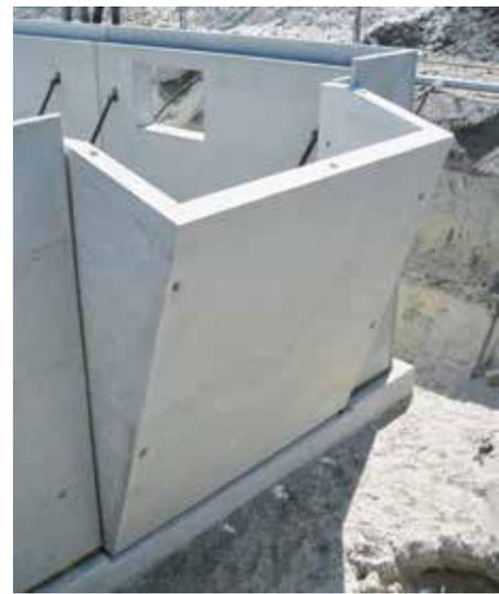
Der Lichtfluter wird als Fertigteil geliefert und gleich bei der Kellermontage mit eingebaut. Er wird abgedichtet und entsprechend den energetischen Anforderungen umlaufend gedämmt.
